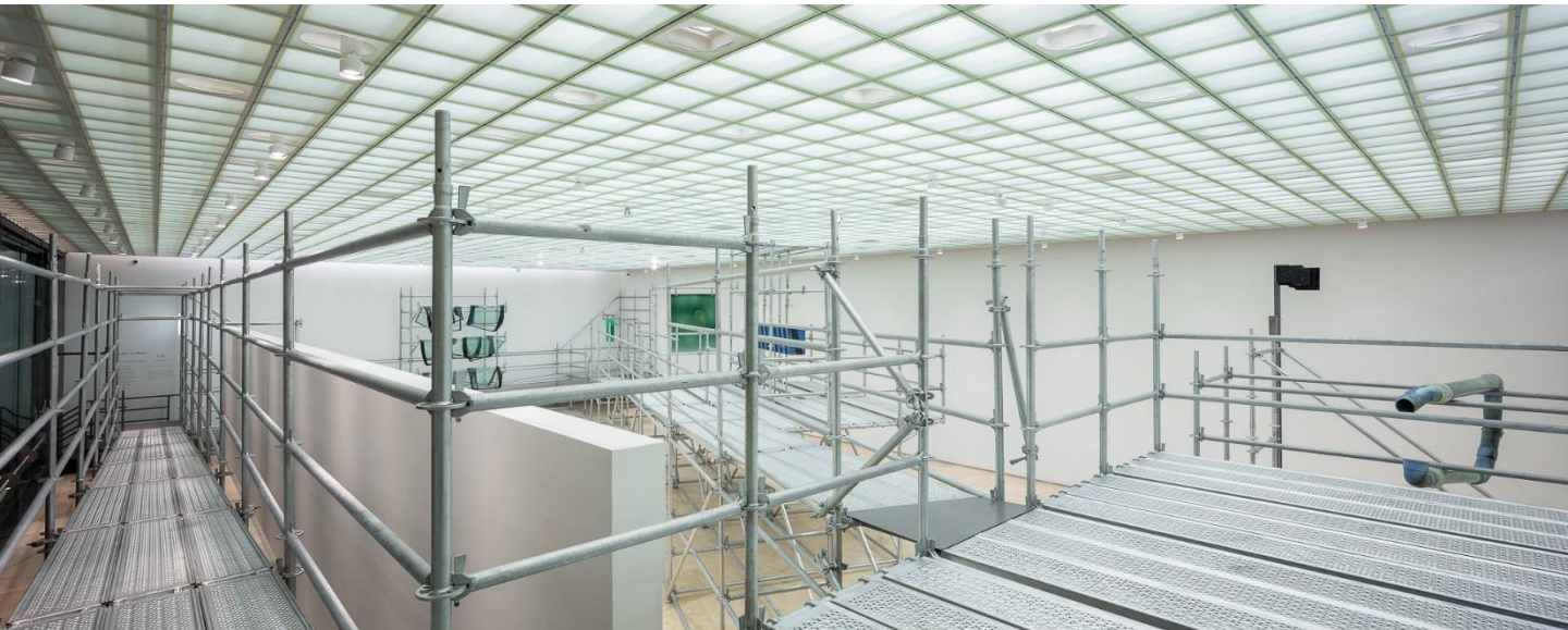
Vista general desde el exterior de la galería (superior) Vista general desde el interior de la galería (inferior)
